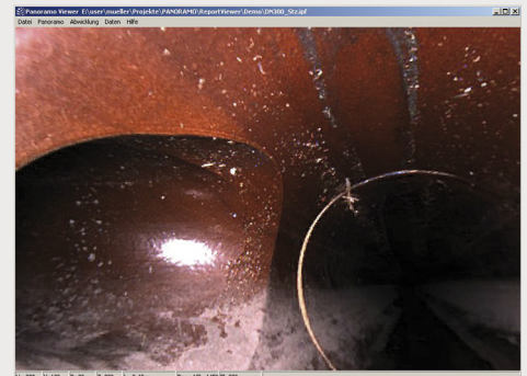
Bild 7: Perspektivische Ansicht eines schadhaften Stützens
